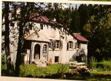
< le porche d'entrée et le jardin << la façade donnant sur la Vallée de Joux
