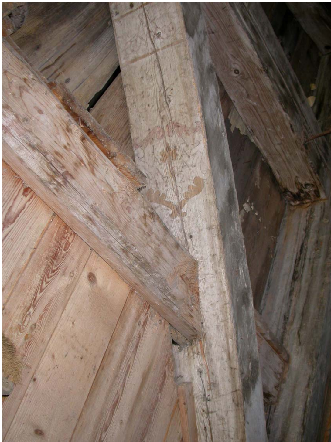
Inscription sur l'une des poutres du néveau. 1720, cela fait une paie !
